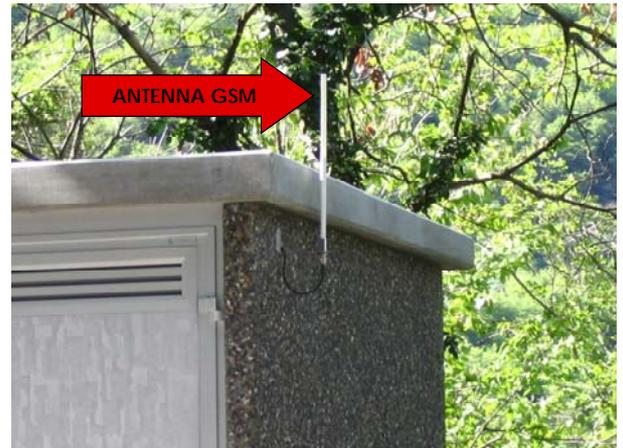
Fig. 2: Dettaglio della cabina Sabbione; la prima telecomandata tramite GSM
