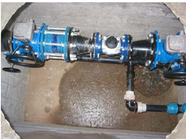
Fig. 17: Dettaglio del collegamento di emergenza
