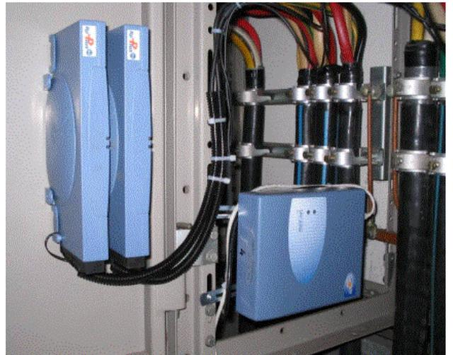
Fig. 8 L'immissione del segnale PLC sulla rete di bassa tensione in cabina
