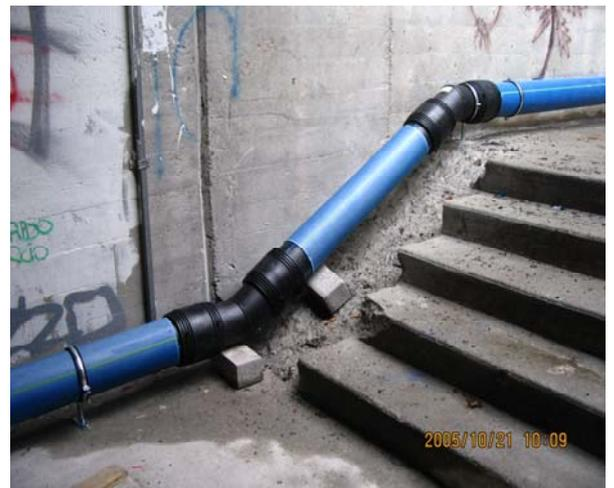
Fig. 16: Dettaglio del collegamento di emergenza
