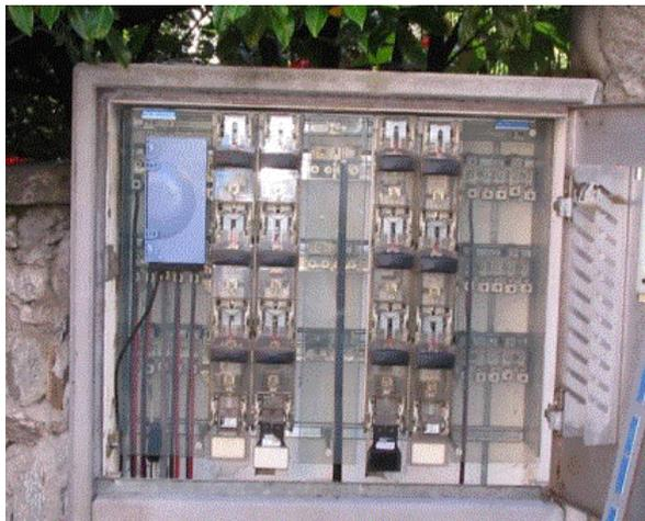
Fig. 9: Un amplificatore del segnale presso un armadietto di distribuzione
